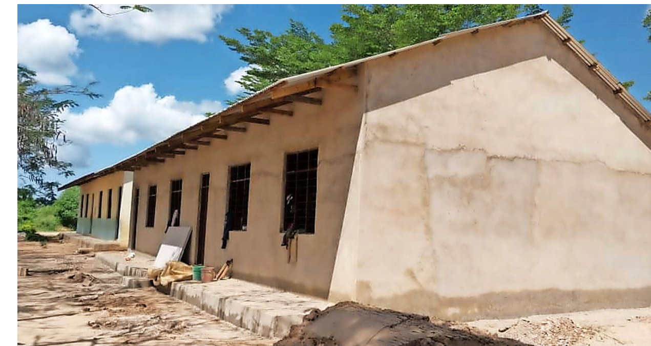
Zwei neue Klassenzimmer für die Grundschule Tumaini wurden hochgezogen, innen verputzt und der Fußboden gegossen. Nun soll das Gebäude ein paar Wochen austrocknen, um dann nach den Juni-Ferien genutzt zu werden.
