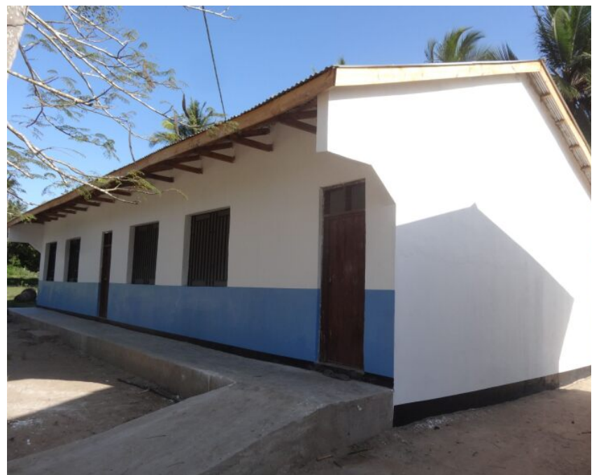
Einen neuen Anstrich erhielt die Grundschule in Kiparang'anda A.
